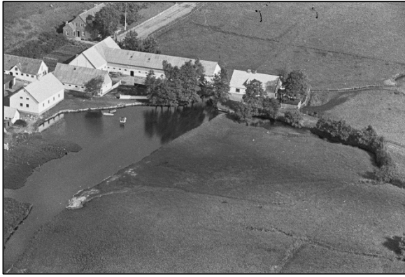
Luftfoto af Røde Mølle i 1950. Vandets indløb til møllehjulet var mellem de to huse, overløbet til højre.
