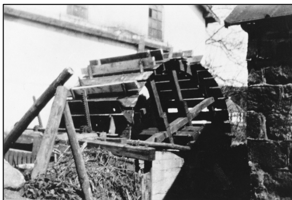
Vandhjulet på Røde Mølle var et underfaldshjul, da der ikke var ret meget fald fra mølledammen til afløbet
