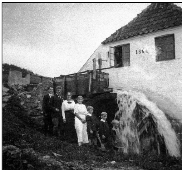
Vandhjulet ved Thingbæk Vandmølle var et overfaldshjul, der her er i drift. Hvem personerne i det fine søndagstøj er, ved vi desværre ikke
