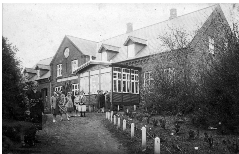
Støvring Højskoles hovedbygning
